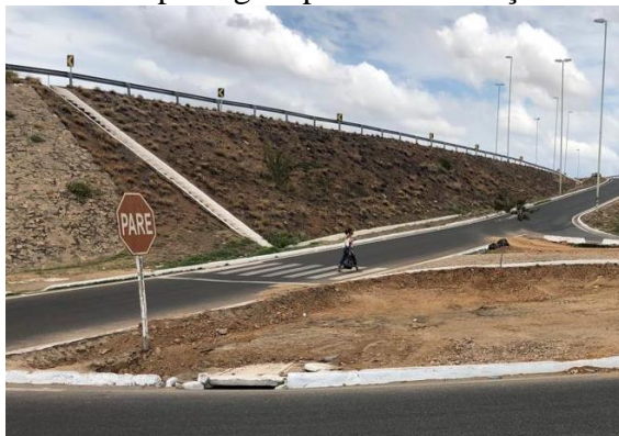
Figura 15 – Taludes do Viaduto dos Barranqueiros Petrolina
