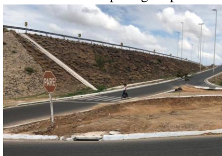
Figura 15 – Taludes do Viaduto dos Barranqueiros Petrolina
