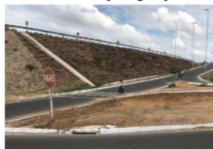
Figura 15 – Taludes do Viaduto dos Barranqueiros Petrolina
